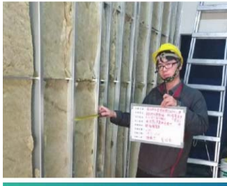
室內裝修分間牆施作
