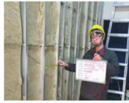
室內裝修分間牆施作
